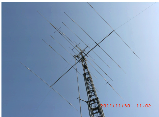
1.9/3.5: full size Dipole 7/10: rotary DP, 18/24 : 2 ele HB9CV, 14/21/28: 5 ele Yagi, 50: 2 ele HB9CV, 144: 5 ele Yagi, 1.2: 10 ele Yagi.
